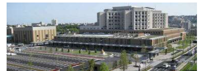
鹿児島市立病院新築空調設備工事
