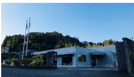
樋脇工場 外観
