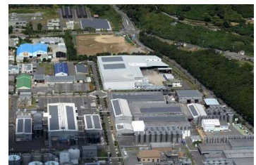
太陽光パネルを設置
