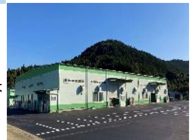
鹿児島工場 第三工場
