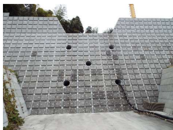
施工例；砂防ダム(緑化基盤)
