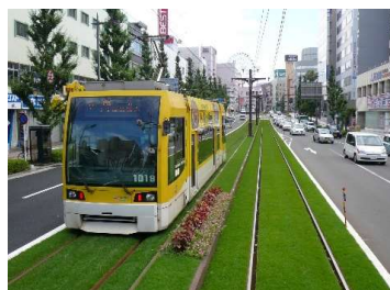
施工例；軌道敷(緑化基盤)
