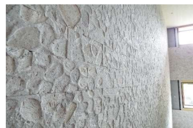
施工例；内装(象がんタイル)
