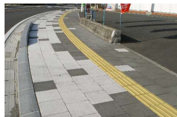
施工例；歩道(多層平板)
