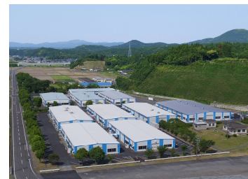
鹿児島工場全景
